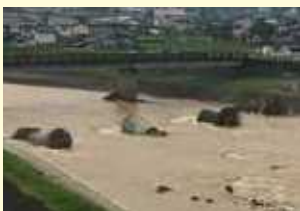
（豪雨后、JR久大線の橋が流された）
